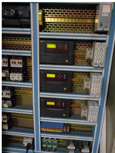
Régulateur pour les circuits du 105
