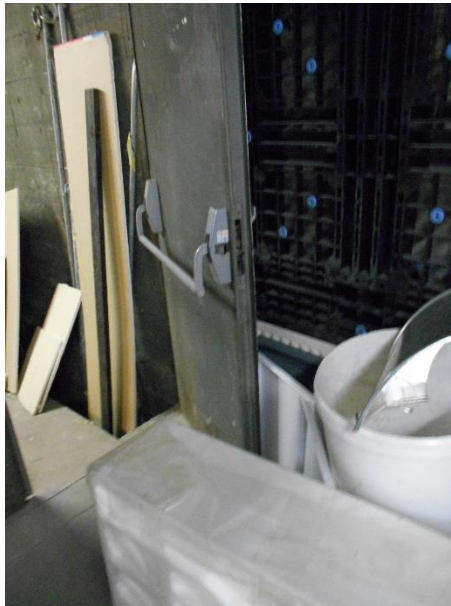
Sortie de chaufferie obstruée
